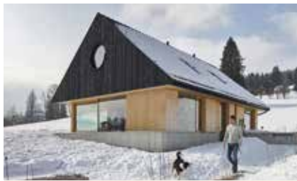
Haus mit GIEBEL Auftraggeber: Familie Lanzerstorfer/Müller Planung: mia2/ARCHITEKTUR ZT KG Holzbau: ALPE Zimmerei und Tischlerei GmbH
