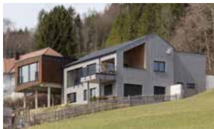
Wohnhaus LW & YOGA Winter Auftraggeber: Brigitte Winter, DI Paul Lakmayer Planung: Mittermayr GmbH Holzbau: Mittermayr GmbH
