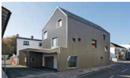
Wohnhaus HS19 Auftraggeber: Brigitte Lechner Planung: Architekt Dipl.-Ing. Bernhard Hannes Eggli Holzbau: Schmid Holzbau GmbH
