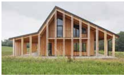
Haus SF Auftraggeber: privat Planung: Mag. Anna Moser Holzbau: Kapl Bau GmbH
