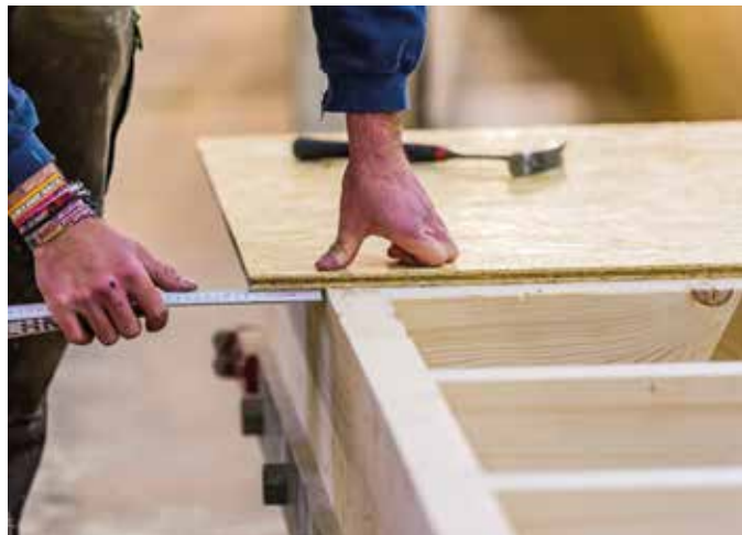
Holzbau-Meister fertigen Holzkonstruktionen im Werk millimetergenau vor.
