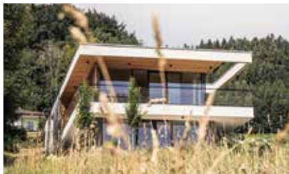
Haus A Auftraggeber: anonym Planung: bau_bar 7 architekten Holzbau: Holz- u. Stahlbau Wimmer GmbH & Co.KG.
