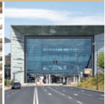
Arch.: Hascher Jehle Architektur, Fotos: Messe Frankfurt GmbH
